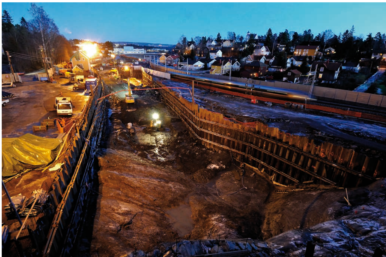
Byggegrøp ved Lysaker stasjon, foto: JBV, Hilde Lillejord
