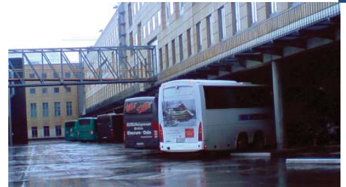
Figur 18 I dag er det totalt 29 plattformer inne på Oslo bussterminal (Foto: Anne Marstein)
