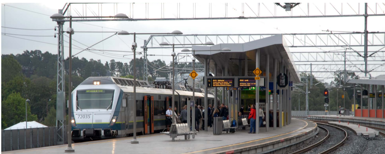
Figur 8: Ferdig utbygd Lysaker stasjon, foto JBV v/ Njål Svingheim
